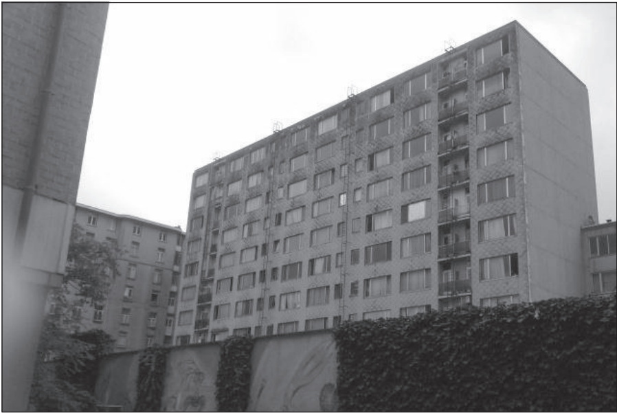
Frank M. klom uit zijn appartement op de vijfde verdieping (links onderaan) en viel op het dak van een garagebox. - Foto SFM
